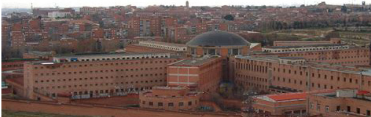
Vista de la Cárcel de Carabanchel en 2003 desde un edificio de la calle Ocaña. Fuente: www.wikiwand.com
